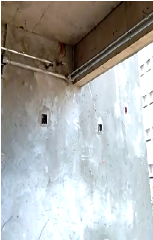
Caixas embutidas na alvenaria
