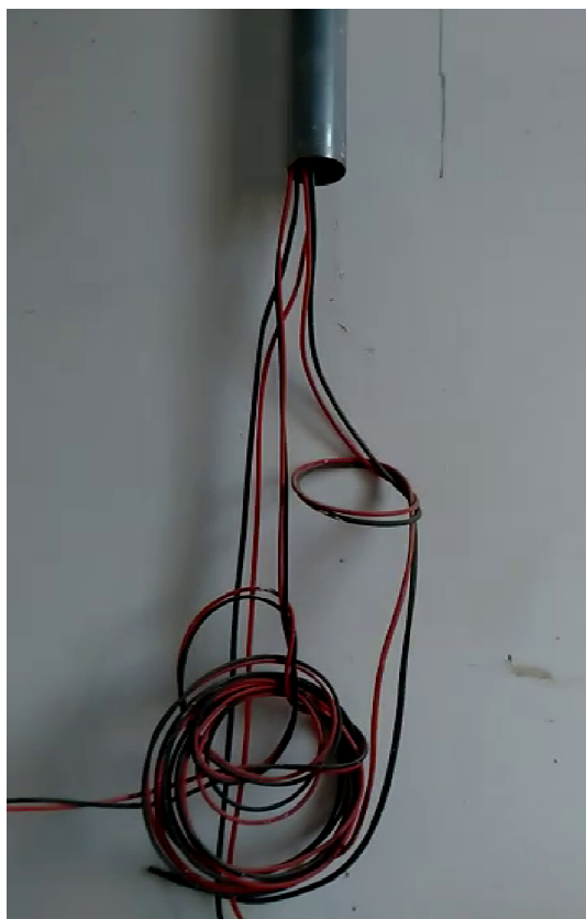
Cabos de iluminação de emergência já lançados
